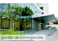
Centro de Emergencias
